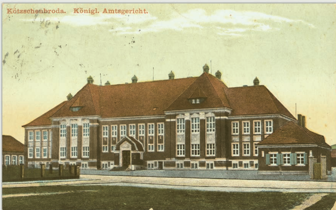
Das neu erbaute Amtsgericht von Kötzschenbroda · Ansicht aus dem Jahr 1910
